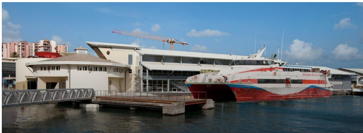
La gare maritime inter-îles de Fort de France – Source GPM de la Martinique
