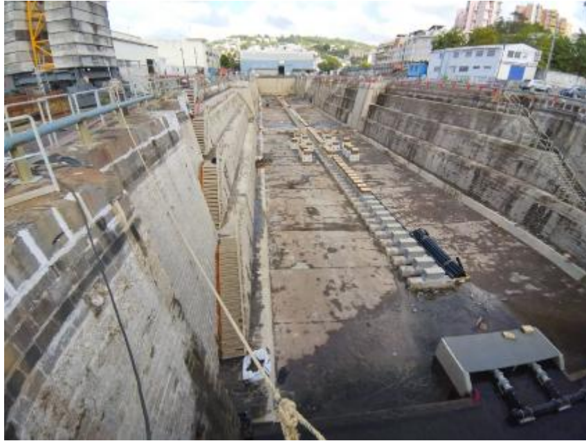
Le bassin de radoub de Fort-de-France, réouvert après rénovation en 2024 – Source GPM La Martinique
