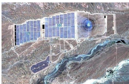
Centrale CSP de Noor, Maroc, Puissance nominale 600 MW sur une surface de 30 km 2
