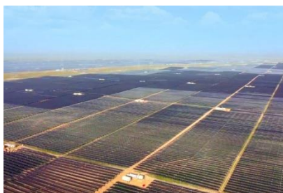
Ferme photovoltaïque, province du Qinghai, Chine. Puissance nominale 2,2 GW 27 km 2
