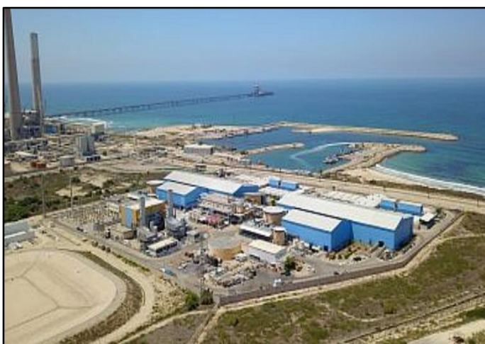
Usine de dessalement à Ashkelon, Israël Source: IDE Technologies Ltd
